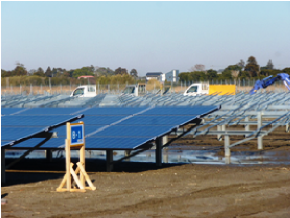
—信友笹島で進む太陽光発電の工事—
