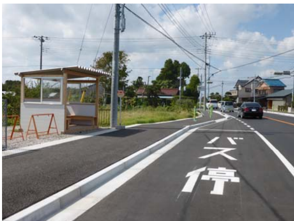
—高根バス停周辺の工事が完成—
